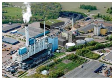
MälarEnergi's planerade samförbränningpanna i Djuphamnen.
